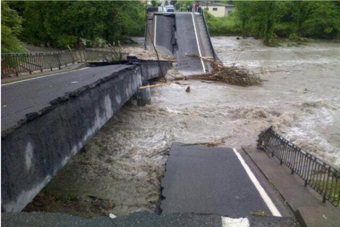
Afbeelding 11: De gevolgen van de crue du Gave de Pau in de zomer van 2013 (bron: http://www.lasemainedespyrenees.fr ). Ondertussen zijn de meeste wegen in het gebied alweer hersteld.
