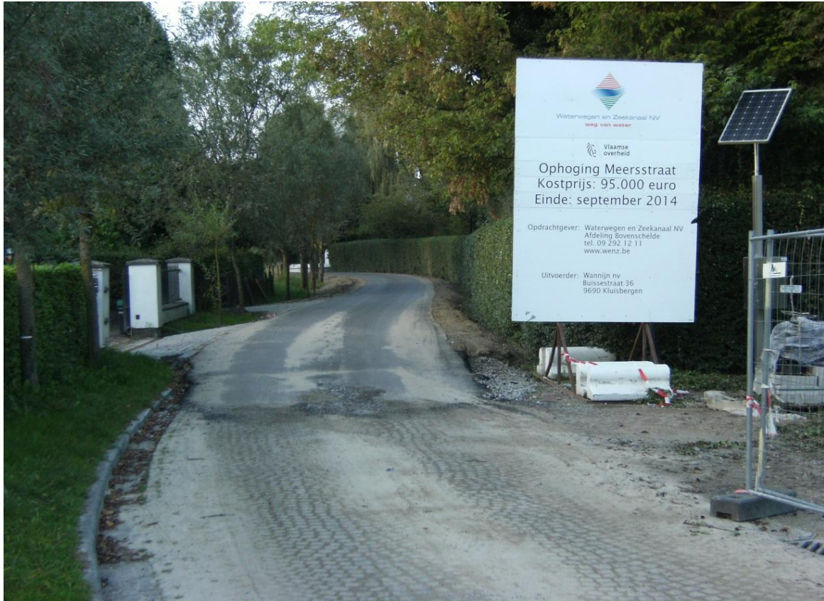
Afbeelding 8: De recente asfaltering én ophoging van het wegdek van de Meersstraat in Sint-Martens-Latem (prov. Oost-Vlaanderen) (foto Bram Vannieuwenhuyze, 2014).
