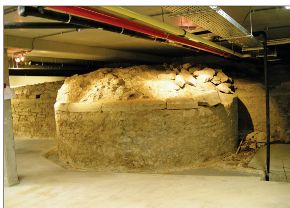
Afb. 30-31. Het Stadskasteel (1382): plan van de opgravingen; bewaarde resten in de kelders van het St.-Augustinus woon- en zorgcentrum.
