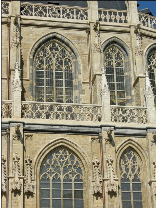
Afb. 34. De toepassing van “blauwe Henegouwse steen” in het koor van de basiliek rond 1408. De willekeurige spreiding deed aanvankelijk vermoeden dat het ging om “ongelukkige” herstellingen wegens het verschil in steensoort.
