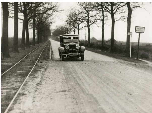
Foto uit 1927 van een niet geïdentificeerde weg op de grens Nederland-België, onder de titel "De slechte toestand van de grote wegen in Nederland in beeld gebracht". Op Nederlands grondgebied is het een steenslagweg, in België een klinkerweg; links ligt een tramspoor en rechts, achter de bomen een aarden zomerweg (bron:
