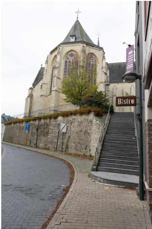
Een trap maakt het mogelijk om het hoogteverschil aan de kerk van Overijse (prov. Vlaams-Brabant) te overbruggen; de autoweg kronkelt zich als een slang rond de kerk (foto Wim Tavernier, 2014).
