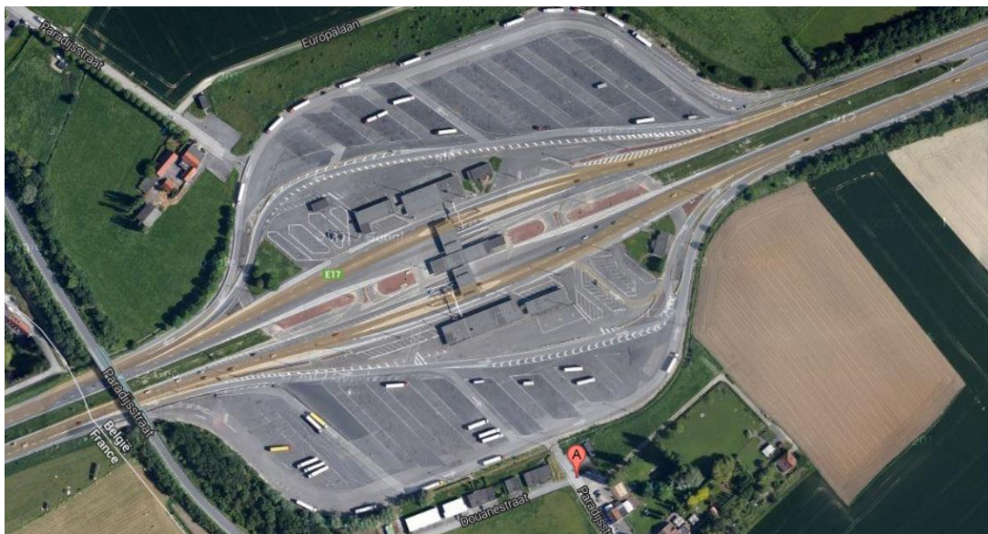
De voormalige grenspost en douaneinfrastructuur aan de Belgisch-Franse grens op de E17 in Rekkem (Menen, prov. W.-Vl.), met onderaan de Douanestraat (luchtfoto Google). De gebouwen werden in 2014 afgebroken in opdracht van Vlaams minister van Mobiliteit en Openbare Werken Hilde Crevits; er is tevens een master- en beeldkwaliteitsplan opgesteld, dat de toekomstige ontwikkeling van de site zal bepalen.
