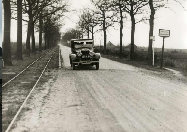
Foto uit 1927 van een niet geïdentificeerde weg op de grens Nederland-België, onder de titel “De slechte toestand van de grote wegen in Nederland in beeld gebracht”. Op Nederlands grondgebied is het een steenslagweg, in België een klinkerweg; links ligt een tramweg en rechts, achter de bomen een aarden zomerweg (bron: http://www.geheugenvannederland.nl/?nl/items/SFA03:SFA022810882 ).
