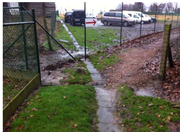
Betonnen voetweg in Ingooigem (Anzegem, prov. West-Vlaanderen; bron: http://eendracht-anzegem.skynetblogs.be/dorp-en-straat/ ).
