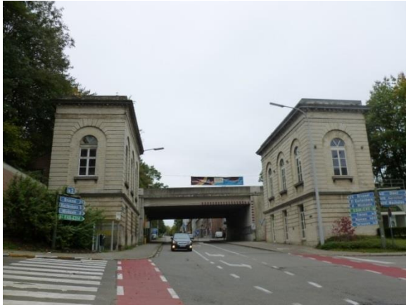
Aan het uiteinde van de Brusselsestraat in Leuven (prov. Vlaams-Brabant), vlak vóór het viaduct van de ringlaan, bevinden zich nog twee neoclassicistische tolhuizen of octrooiegebouwen, gebouwd in 1825 (Glabek 2011: 99; zie ook Inventaris van het Bouwkundig Erfgoed, ID 206454) (foto Andrea Bardyn, 2014). Één van de zijstraten ten zuiden van de Brusselsestraat verwijst ernaar: Tolhuizenstraat.
