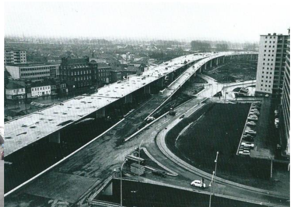
Aanleg van het Zuidviaduct in Gent (prov. Oost-Vlaanderen), waarlangs men vanop de E17 rechtstreeks met de wagen het stadscentrum kon binnenrijden (overgenomen uit Laleman e.a. 2012: 109).
