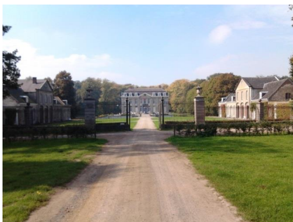
De toegangsweg tot het kasteel van Leeuwerghem (Zottegem, prov. Oost-Vlaanderen, Inventaris van het Bouwkundig Erfgoed, ID 9783), een landhuis opgericht in het eerste kwart van de achttiende eeuw in opdracht van L. François d'Heyne, ter vervanging van een waterslot verwoest in 1656 (foto Bram Vannieuwenhuyze, 2014).
