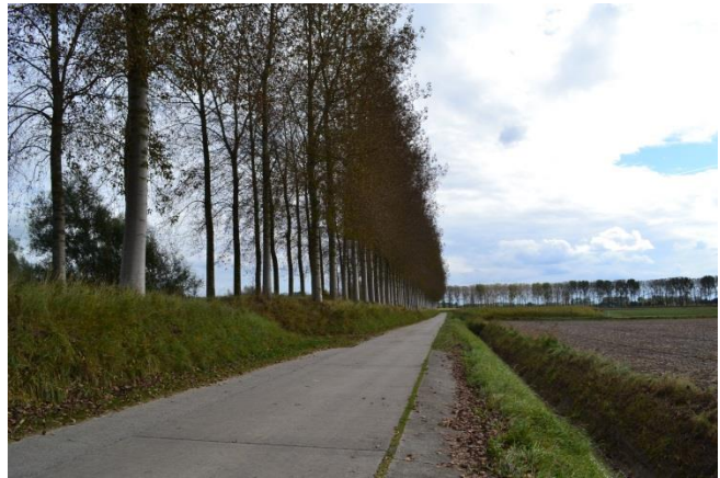
De Beoostereedepolderdijk in Sint-Laureins (prov. Oost-Vlaanderen) loopt aan de binnenzijde van een dijk.
