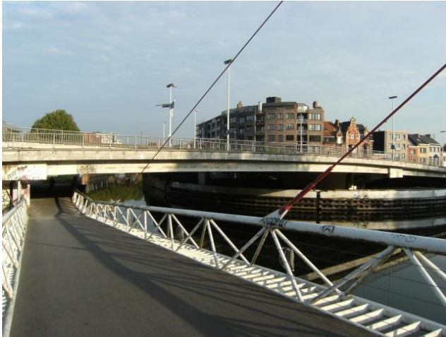
Het Keizersviaduct, onderdeel van de ring van Gent (prov. Oost-Vlaanderen). De ruimte die dankzij het viaduct is vrijgekomen heeft de aanleg van een fietsersbrug en grafittiplek mogelijk gemaakt (foto Bram Vannieuwenhuyze, 2014).
