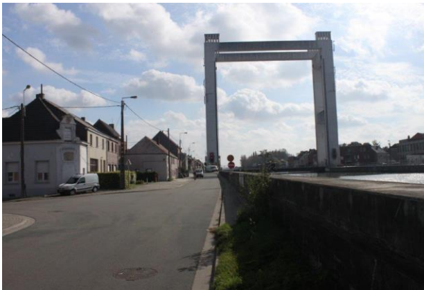
De Sluisweg leidt naar het gehucht Sas (Grimbergen, prov. Vlaams-Brabant), waar zich sinds 1968 de Humbeekbrug over het Zeekanaal Brussel-Schelde bevindt (foto Hugo De Maeyer, 2014).
