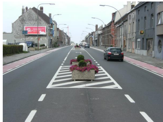
De Brusselsesteenweg in Halle (prov. Vlaams-Brabant), ooit één van de eerste achttiende-eeuwse steenwegen in de Zuidelijke Nederlanden, nu een zeer drukke en brede asfaltweg (foto Elisabeth Vercammen, 2014).
