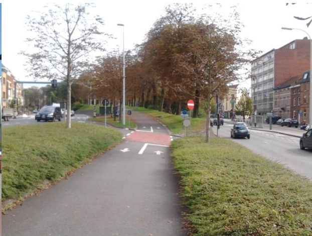
De Naamsevest (links) en Erasme Ruelansvest (rechts) in Leuven (prov. Vlaams-Brabant), onderdeel van de ringlanen rondom de historische binnenstad. Centraal bevindt zich nog de talud van de voormalige stadsomwalling, nu ingericht als park met fietspad (foto Bram Vannieuwenhuyze, 2014).
