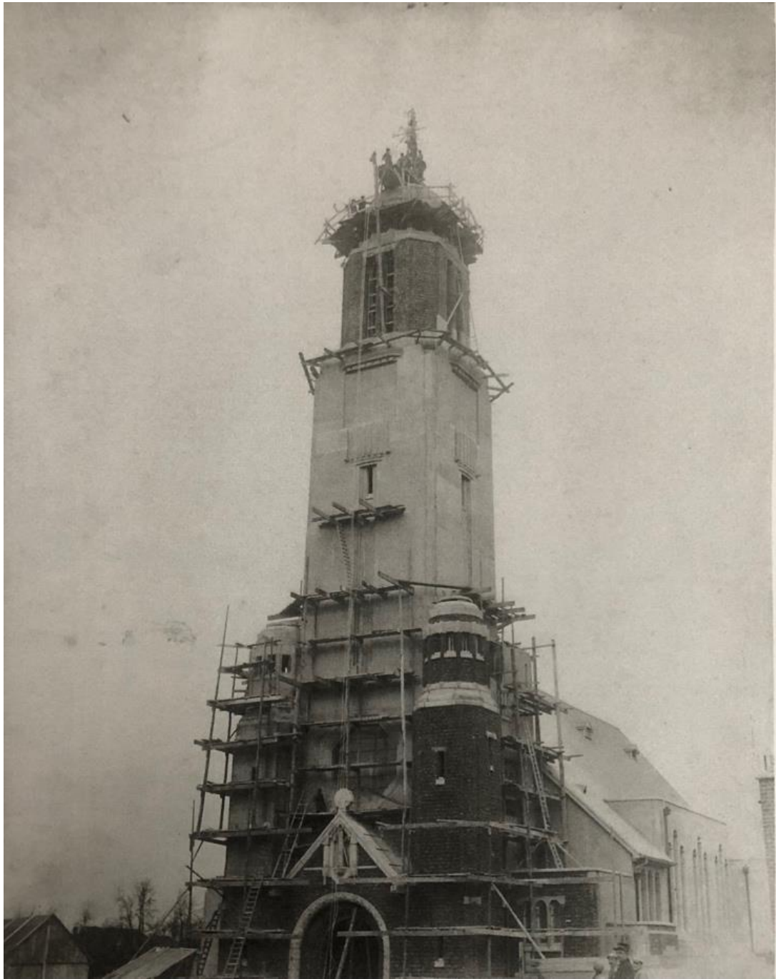
Afb. 3.13: Aanbrengen van grindbepoistering aan kerktoren, 1927-1928. – Bron: AKSR.
