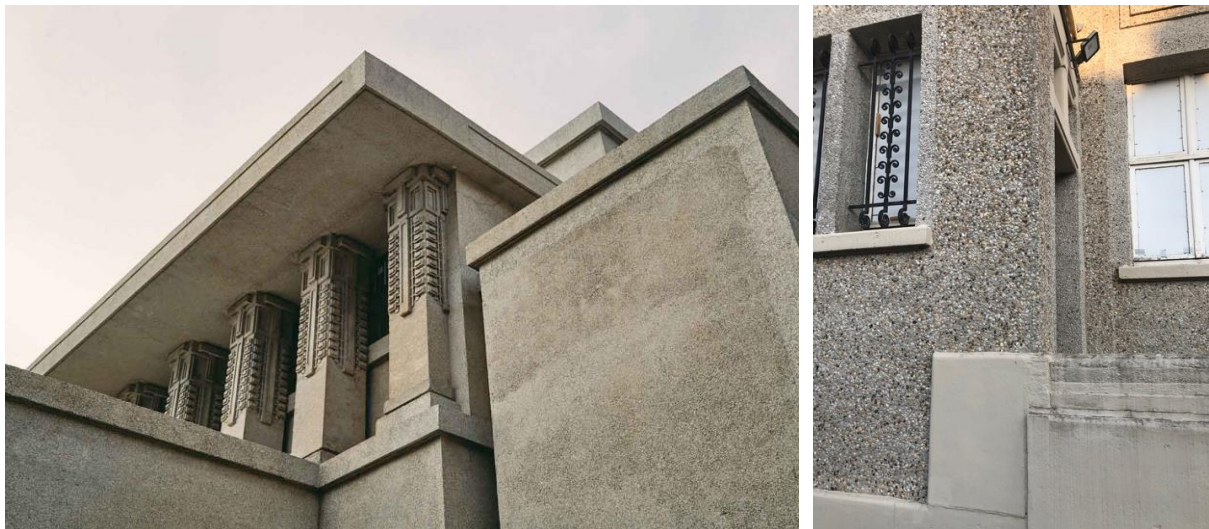
Afb. 3.66 en 3.67: Vergelijking cementbeploistering met keien van Unity Temple versus Sint-Rochuskerk in Halle, 7 mei 2022 – Bron: OutTheretravel & eigen foto.
