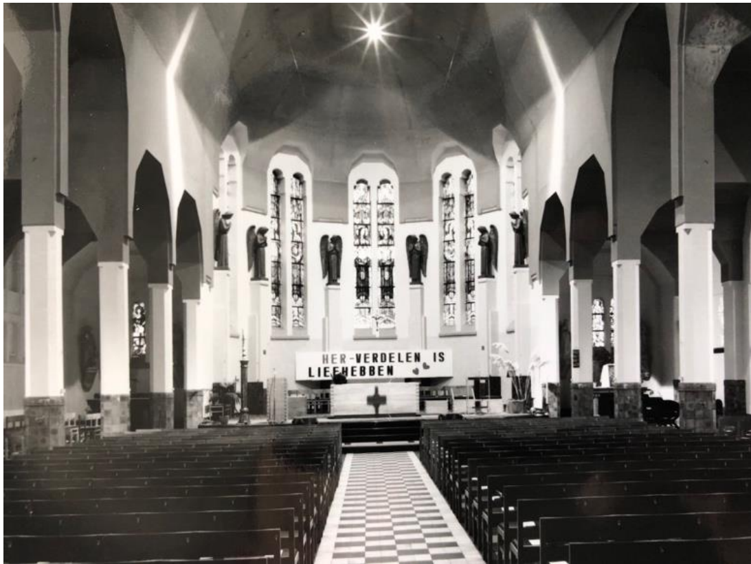
Afb. 3.38: Interieur kerk, ongedateerd. – Bron: Bouwtechnisch en Materiaal-technisch vooronderzoek, iconografie 1.
