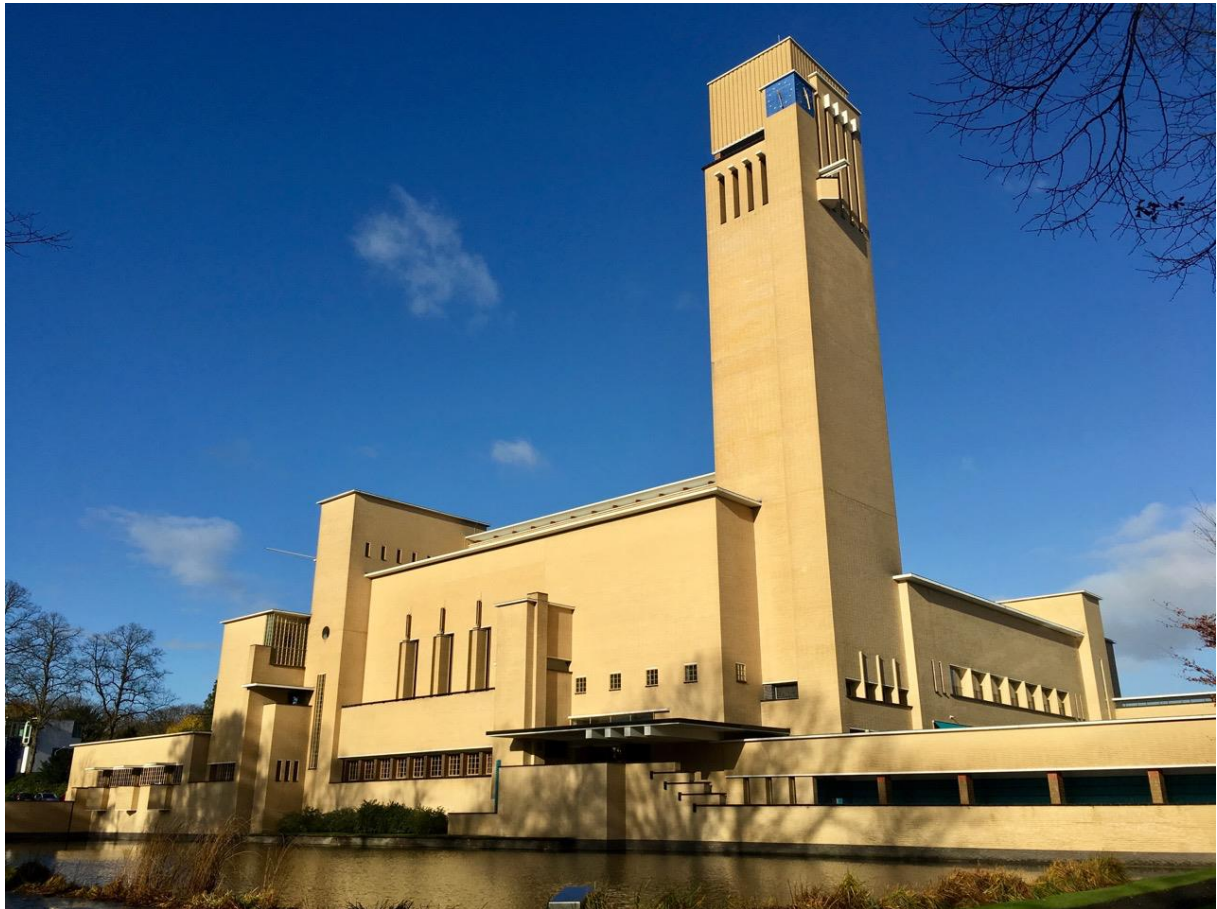
Afb. 3.59: Stadhuis Hilversum. – Bron: Dudok Architectuurinstituut.
